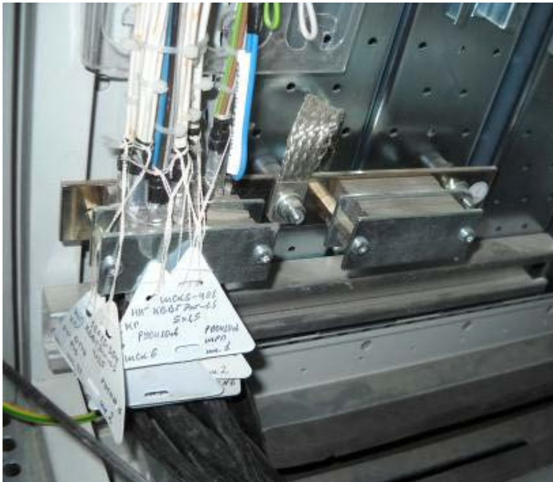
Рис. 5-2 Способы заземления экранов кабелей.
